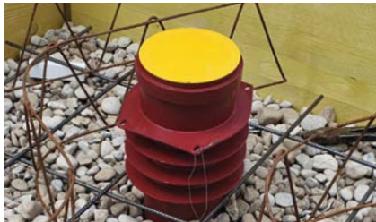
Einrichten auf Oberkante Fundamentplatte
