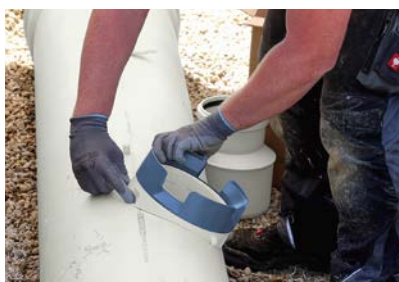
8. Mit Finger zentrieren und festziehen.
