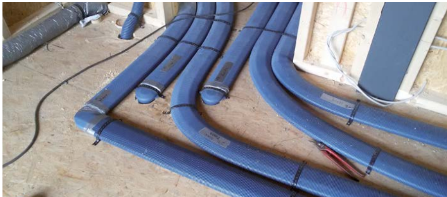
Verbindungsstellen mit Kaltschrumpfband abkleben
