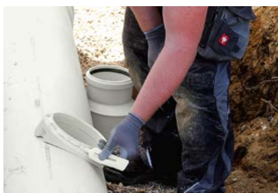
7. Gleitmittel auf Gewinde auftragen.
