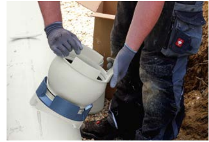
12. Kugel DN 200 von Hand anziehen.
