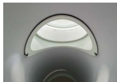
9. Innenflansch auf korrekten Sitz prüfen (Tastprüfung).
