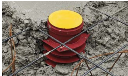
Betonieren und rütteln
