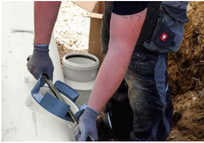
10. Durch 90° Drehung festziehen
