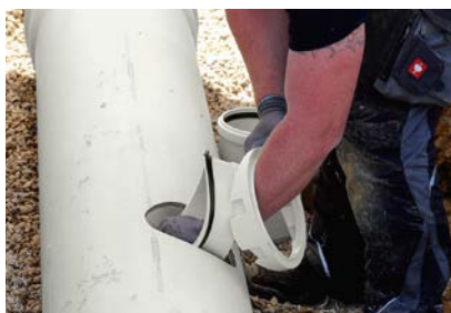
4. Innenflansch in das Bohrloch einsetzen.
