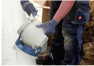
11. Gleitmittel auf Gewinde auftragen.
