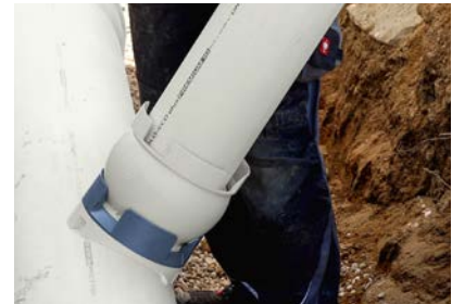
15. Rohranschluss herstellen: DN 200 +/- 8°; Bogen bis 45°.
