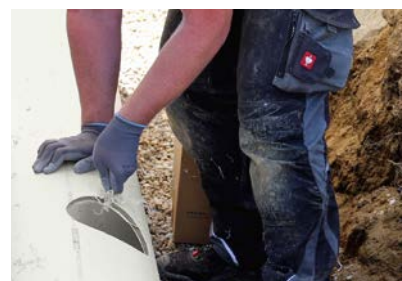
3. Bohrloch innen und außen entgraten.
