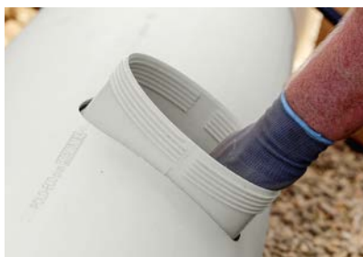
5. Innenflansch korrekt positionieren.
