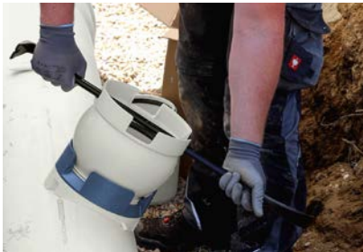
13. Kugel DN 200 festziehen.
