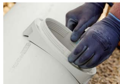
6. Ausgleichsring durch Einrasten fixieren.
