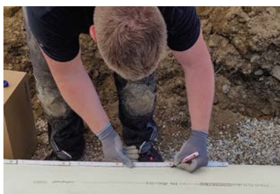
1. Rohr reinigen, messen und anzeichnen.
