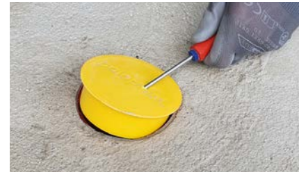
Bauschutzdeckel entfernen
