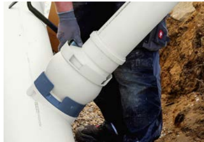
14. Rohranschluss herstellen: DN 160 +/- 6°.
